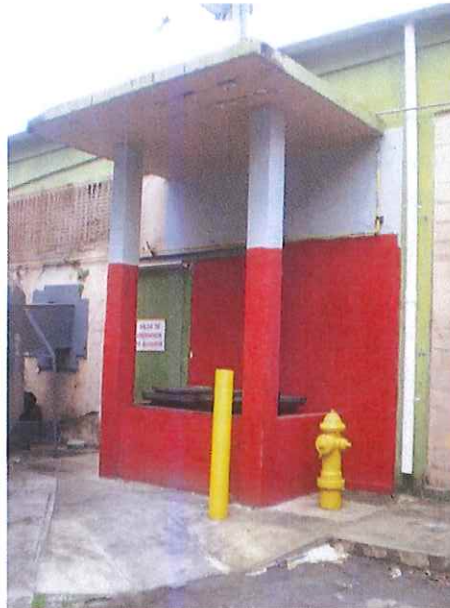
Dique con techo
